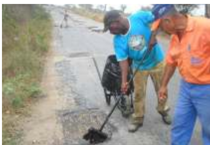
Os buracos já estão sendo tapados
